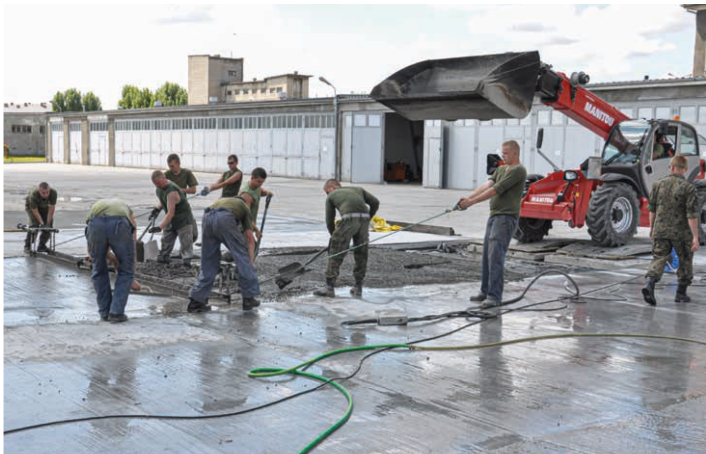
Specjaliści z Jarocina remontują uszkodzenia nawierzchni, niwelują koleiny, naprawiają ubytki infrastruktury lotniskowej.
