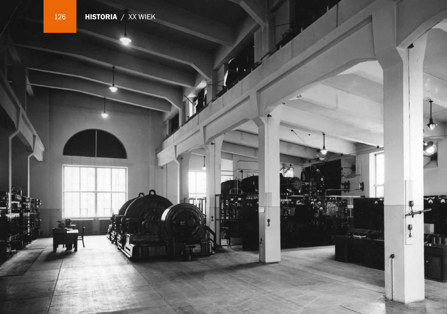
Pomieszczenie z generatorami transatlantycznej stacji radionadawczej
