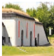
Pod koniec 2017 roku władze gminy rozpoczęły przygotowania do rewitalizacji znacznie większego obiektu – dzieła międzyfortowego Kobylany I. Po niemal dwóch latach, w połowie kwietnia, udało się zakończyć restaurację.
