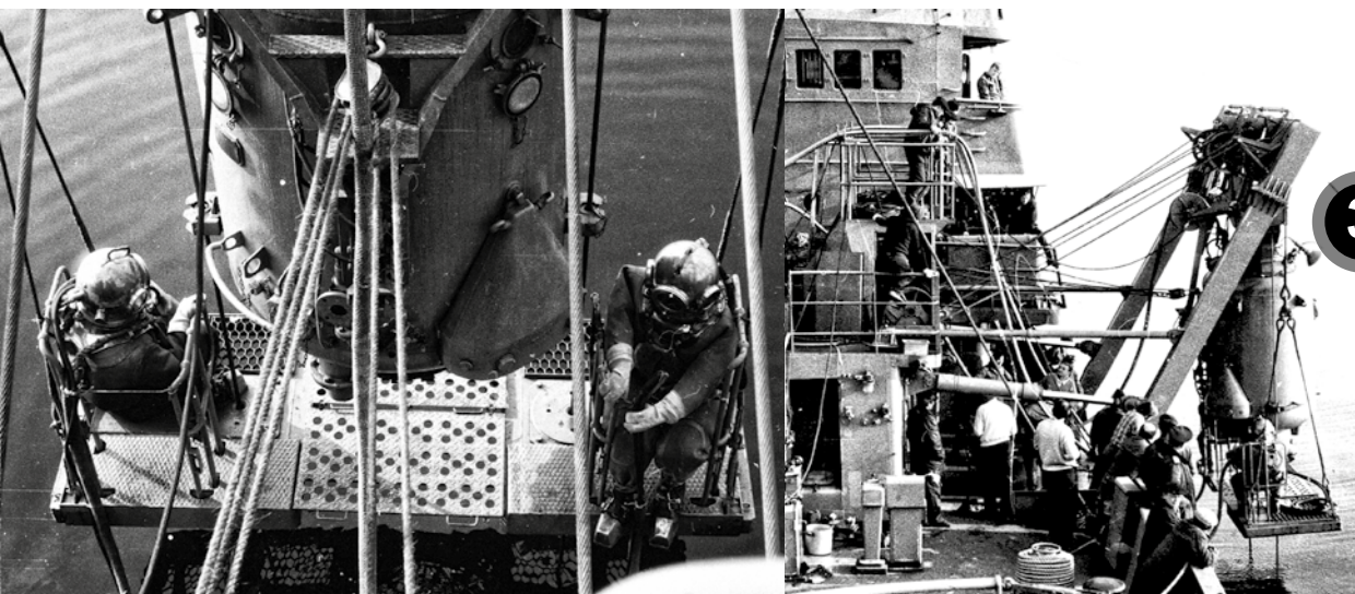
Pierwsze próby technologii nurkowań głębokich z dzwonem nurkowym okrętu ORP „Piast” (1974)
