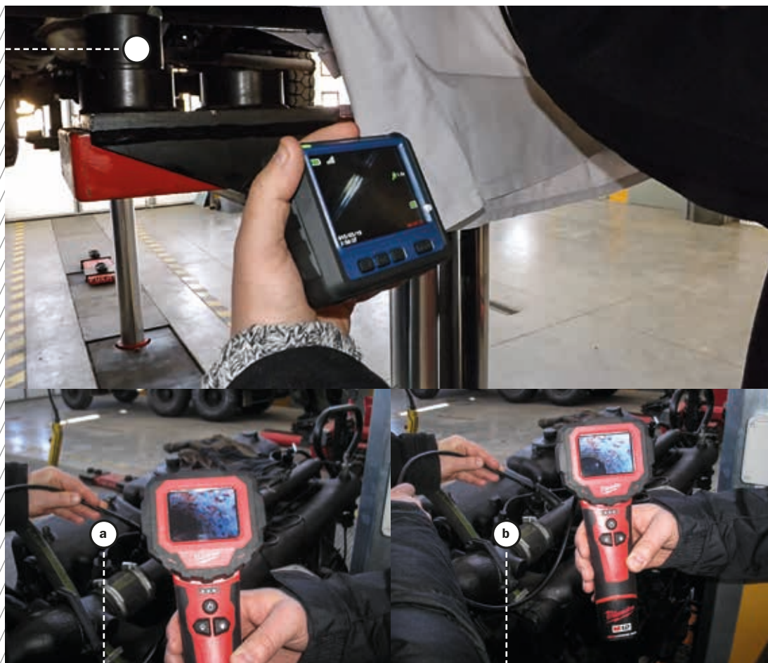
Fot. 2. Widok początku (a) i końca (b) wnętrza przewodu kolektora wodnego
