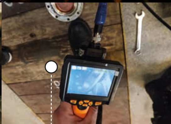
Fot. 5. Widok elementów mocujących przekładni
