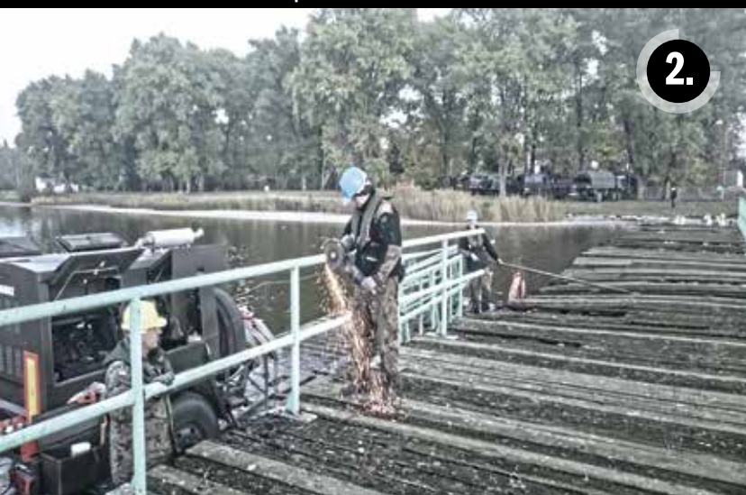
Rozbiórka zdewastowanego pomostu w Żninie
