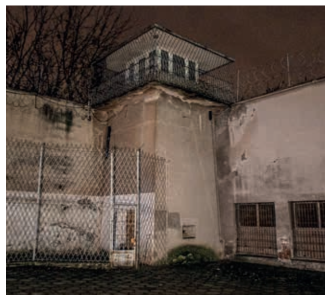
Budka strażnicza na dziedzińcu więzienia
