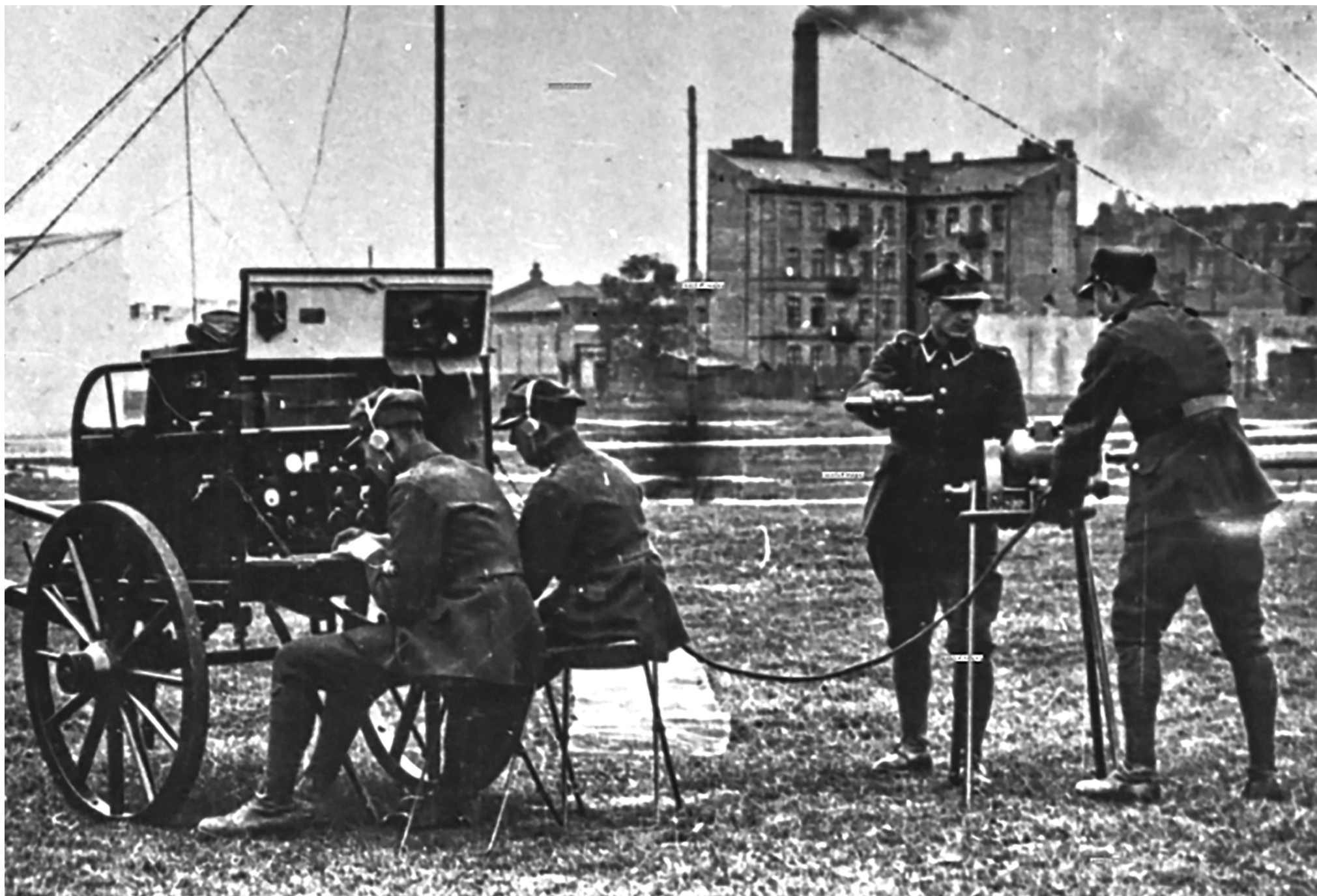
Radiostacja przesyłowa TYB1 była w początkach lat dwudziestych XX w. nowoczesną konstrukcją opracowaną w brytyjskiej firmie Marconi's Wireless Telegraph Co. W Polsce, użytkowana pod oznaczeniem RKA (radiostacja korespondencyjna armii), służyła do utrzymywania łączności na szczeblu dywizji i armii. Miała zasięg do 250 km.
