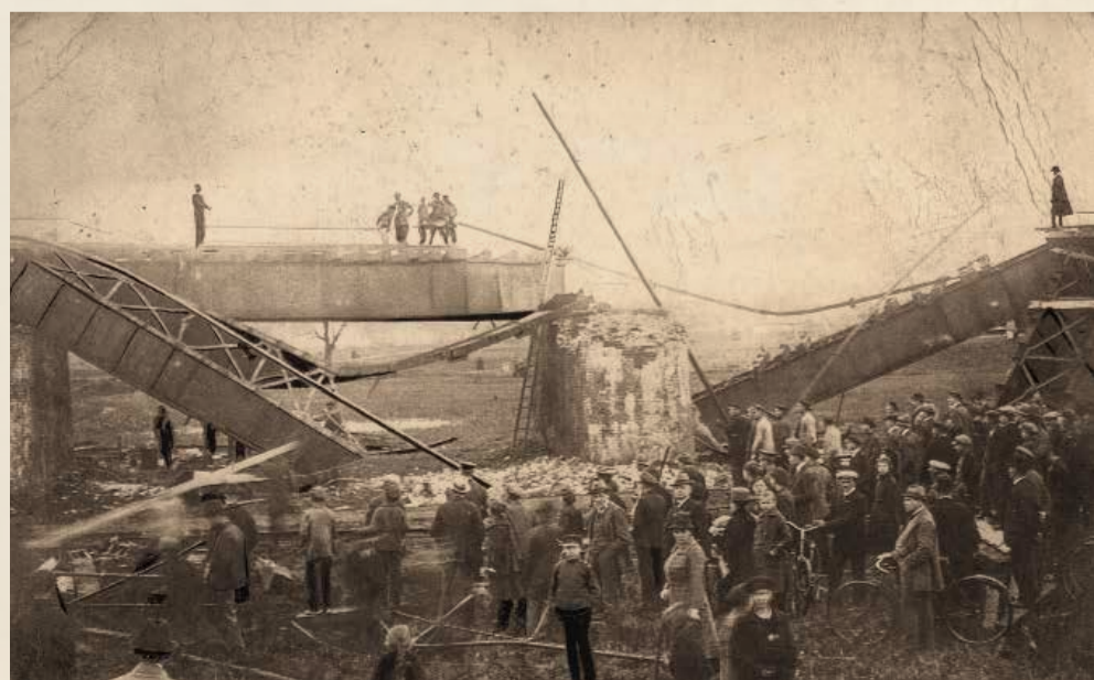
Zniszczony przez oddział Wawelberga most pod Szczepanowicami (obecnie dzielnica Opola). Fot. Zbiory Muzeum Czynu Powstańczego
