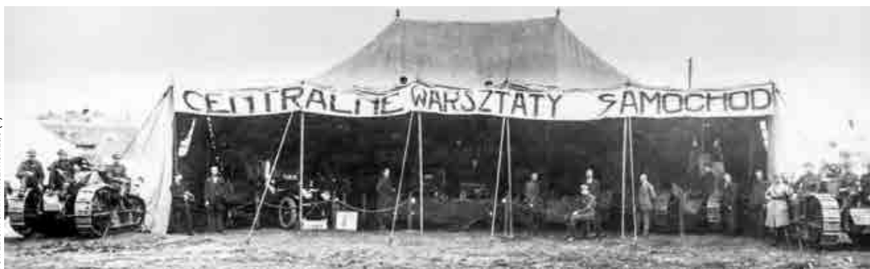
Wystawa dokonń Centralnych Warsztatów Samochodowych w 1925 r. Po lewej i prawej stronie – zbudowane w Centralnych Warsztatach Samochodowych ćwiczebne czołgi Renault FT-17 z blach niepancernych.
