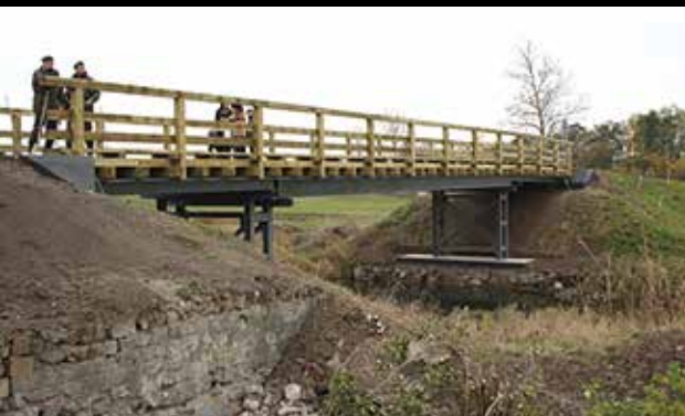
Odbudowany most na Kanale Noteckim
