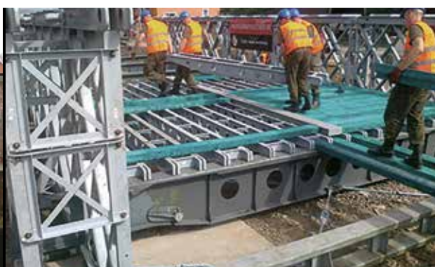
Budowa jednego z mostów w rejonie Jeleniej Góry
