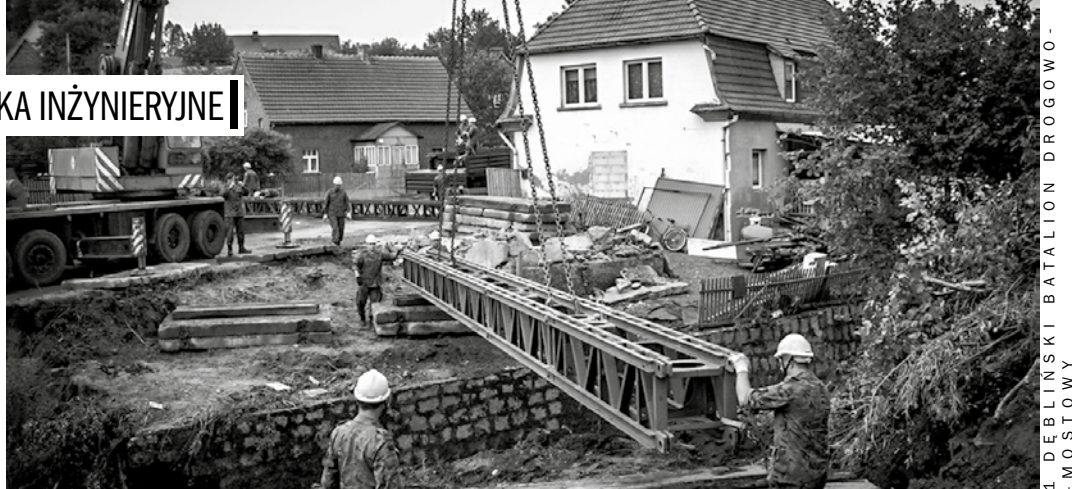
Żołnierze 1 Dęblińskiego Batalionu Drogowo-Mostowego podczas budowy tymczasowej przeprawy
